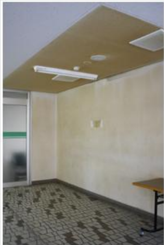
北別館の喫煙室があった場所。仕切りがあった部分だけ、天井や壁がヤニで変色している
