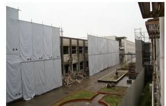
<中庭の撤去と、防塵・防音シート設置工事>
