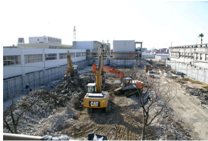
〈 第2棟跡地と、重機によるコンクリート破砕作業 〉
